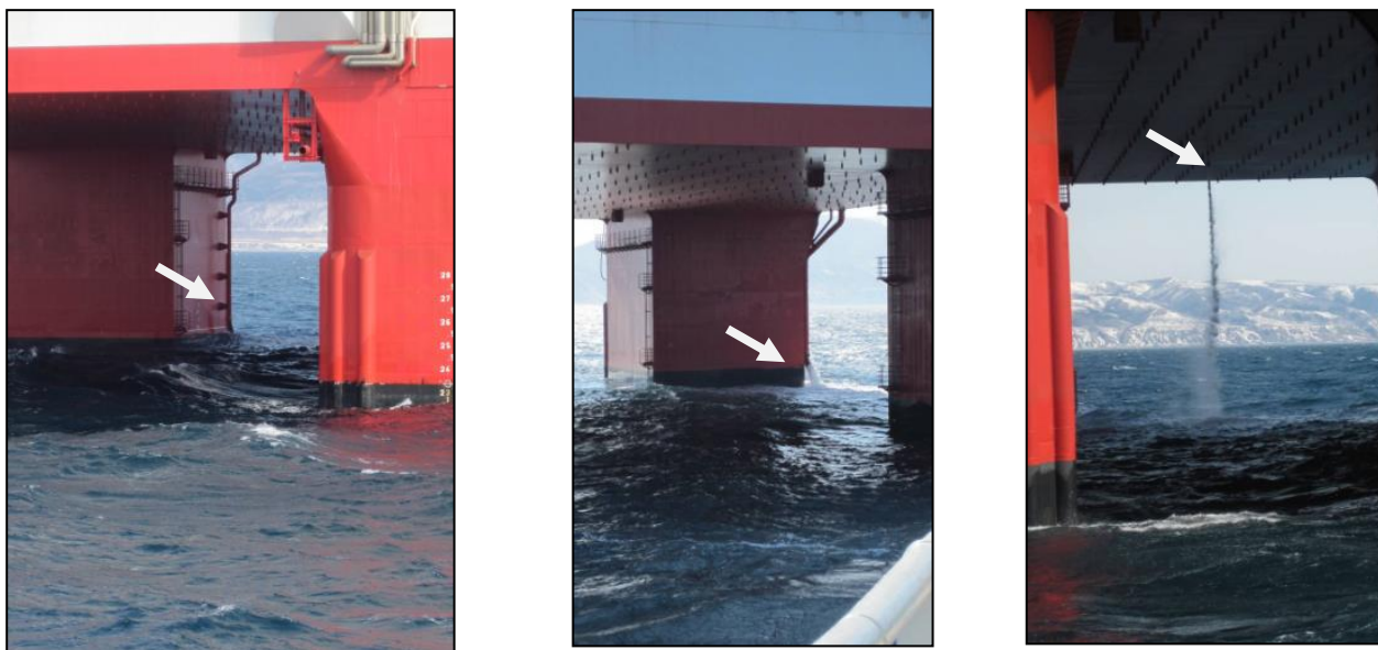
Рисунок 7.1 – Сброс вод из системы охлаждения дизель-генераторов и вспомогательных механизмов
