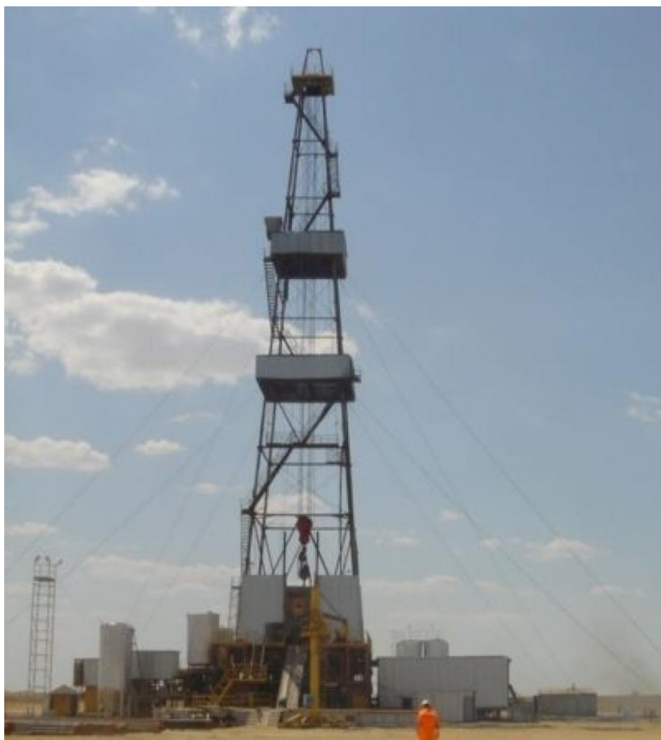
Рисунок 7.1 – Общий вид установки БУ ЗД-86
