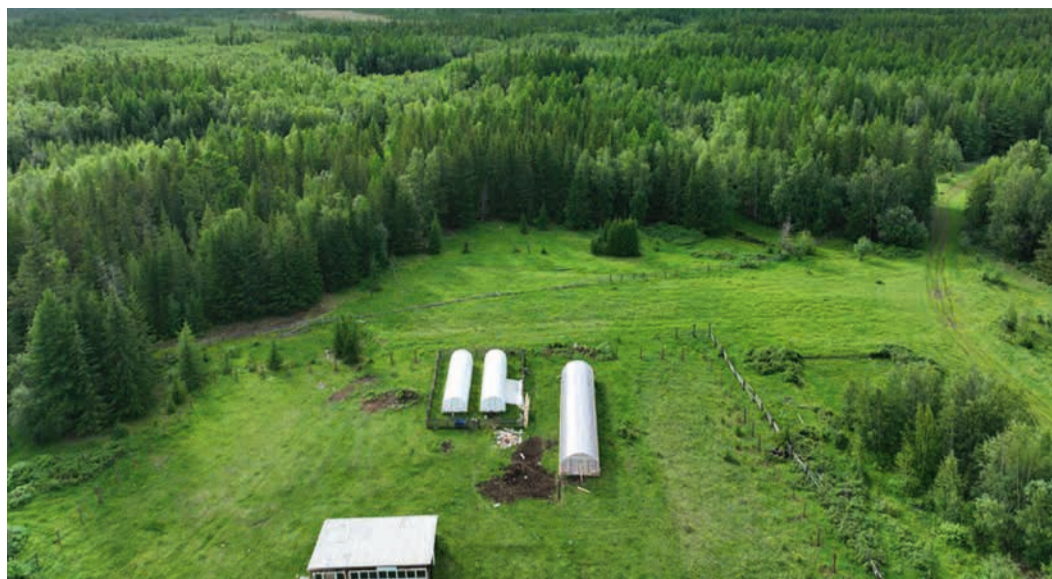
Теплицу смонтировали на школьном приусадебном участке
