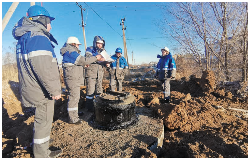
На строительстве водопровода для НПФ «Оренбурггазгеофизика»
