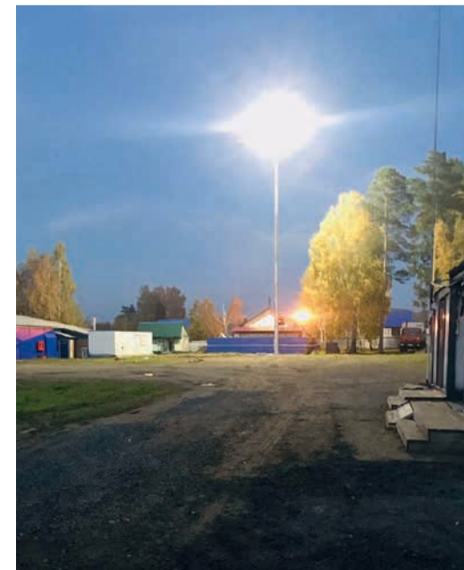
Установлены светильники мощностью 3,3 кВт.
