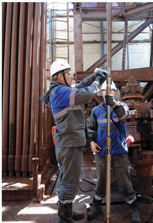
Монтаж связки КПБ на скважине производят Роман Шамина и Андрей Ломакин
