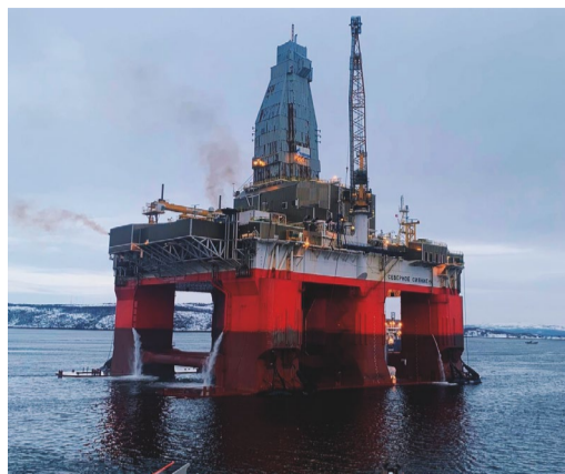
ППБУ «Северное сияние» демобилизована в Кольский залив
