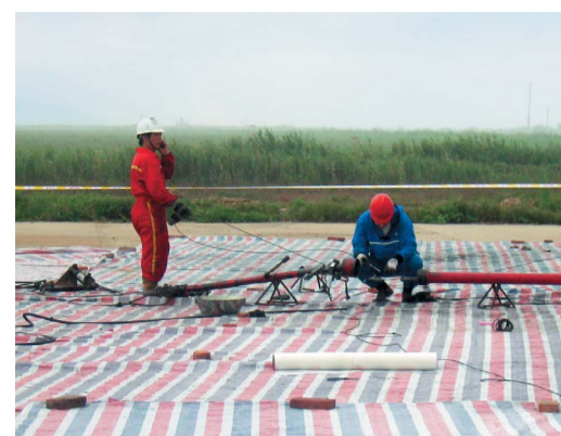
Выполнение работ на ПХГ Дачжанто (КНР)
