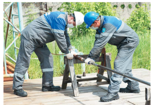
Сборка скважинного прибора
