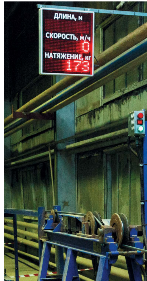
Участок разметки геофизического кабеля и гидравлического испытания устьевого оборудования
